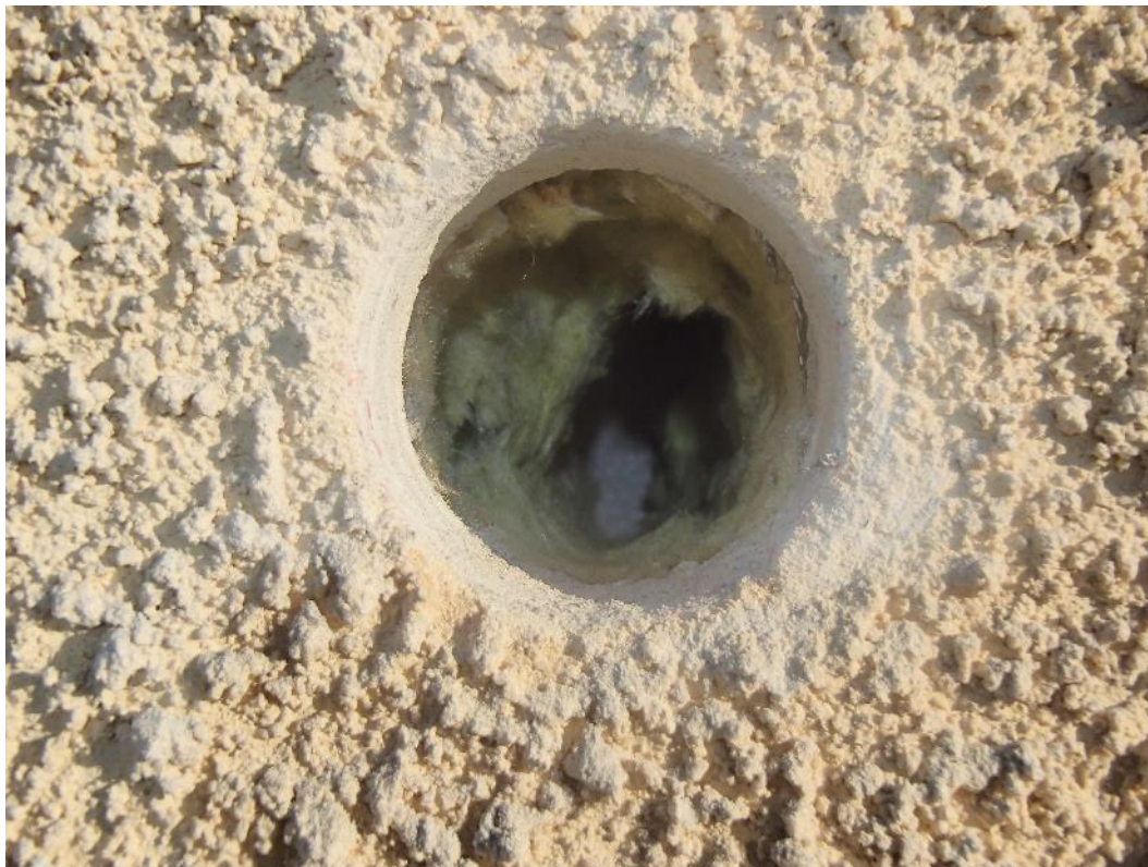
Kuva 5. Rakenneavaus ulkovaipparakenteeseen.
